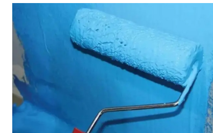
防水涂料施工
