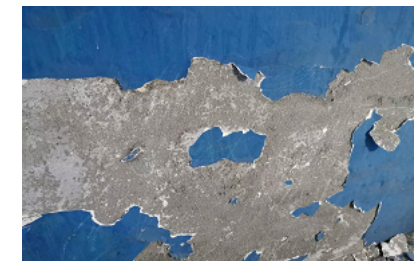
涂层失水太快影响涂膜与基层粘接性
